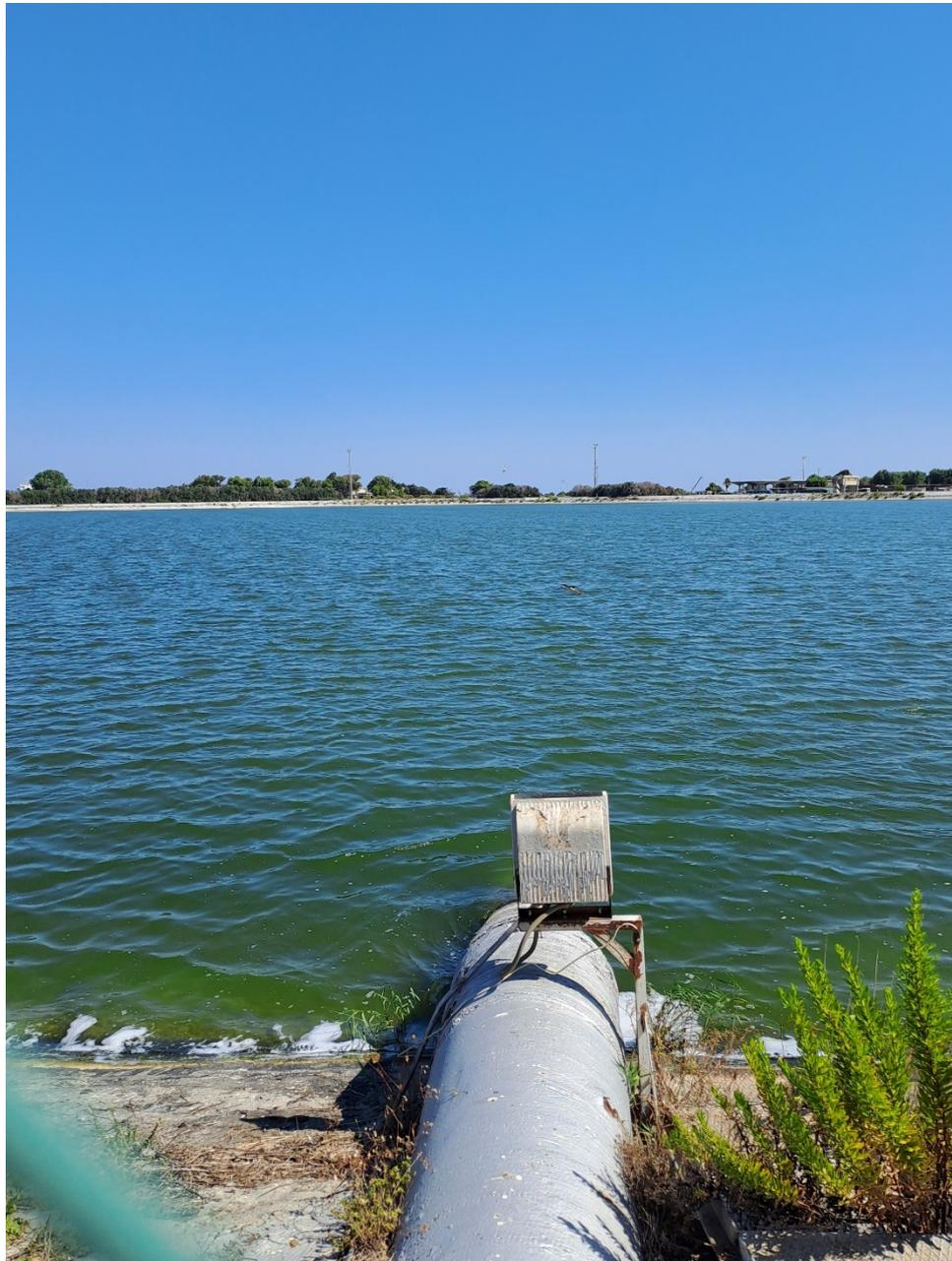
**Figura 2-10: Condotta DN800 di immissione acque da Invaso di Fiume Grande a Bacino Interno allo stabilimento. Vista in corrispondenza del termine, al suo sbocco nel bacino di raccolta. [Fonte: sopralluogo diretto eseguito in data 31/07/2024]**
