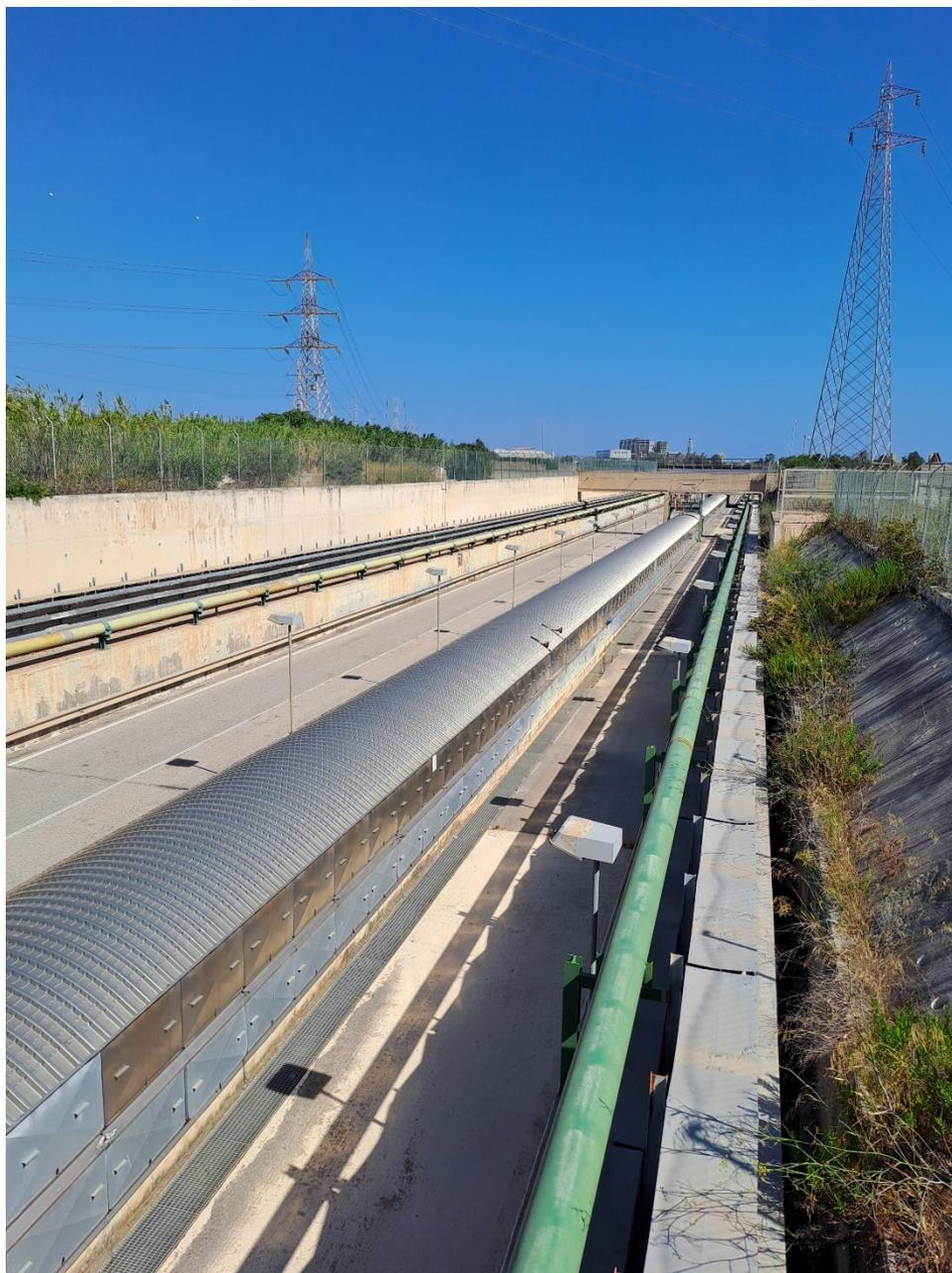
**Figura 2-4: Asse attrezzato del carbonodotto a servizio della centrale Enel Federico II [Fonte: sopralluogo diretto eseguito in data 31/07/2024]**
