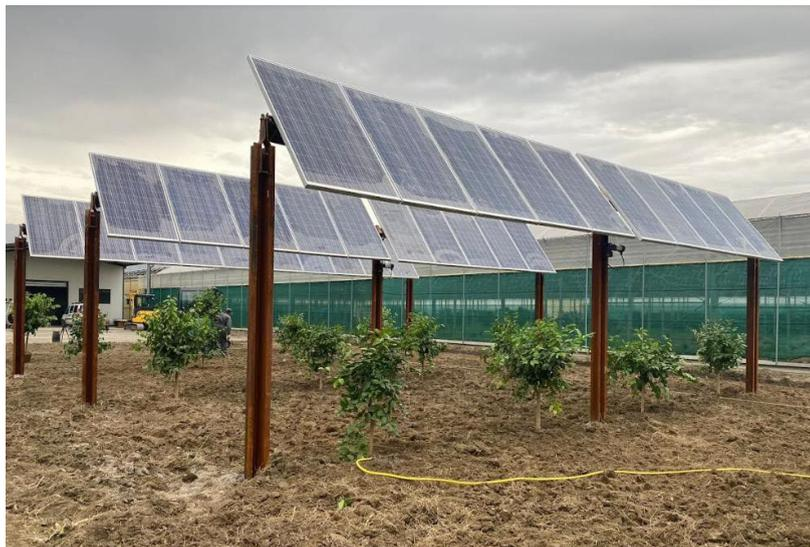
Foto 1 - esempio Tracker per impianti agrivoltaici
