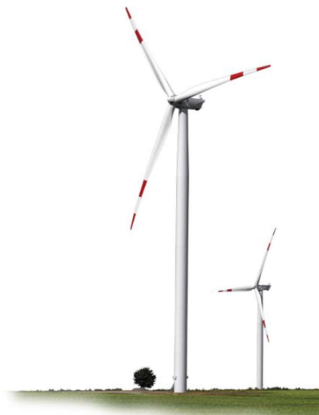
Figura 34 Esempio di aerogeneratore
