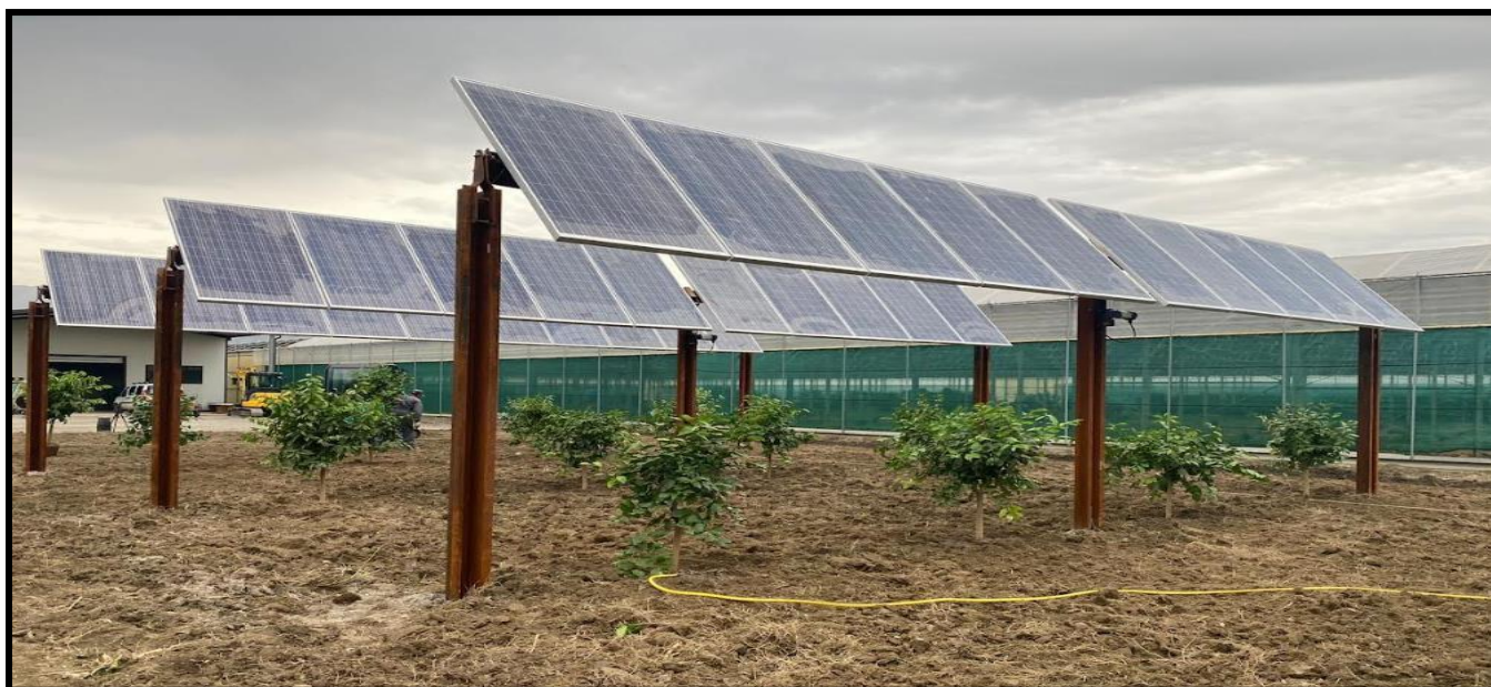
Immagine 2.3 - esempio tracker per impianti agrivoltaici
