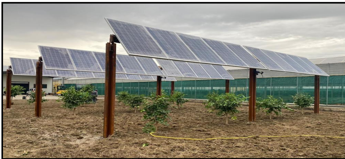
Immagine 2.3 - esempio tracker per impianti agrivoltaici
