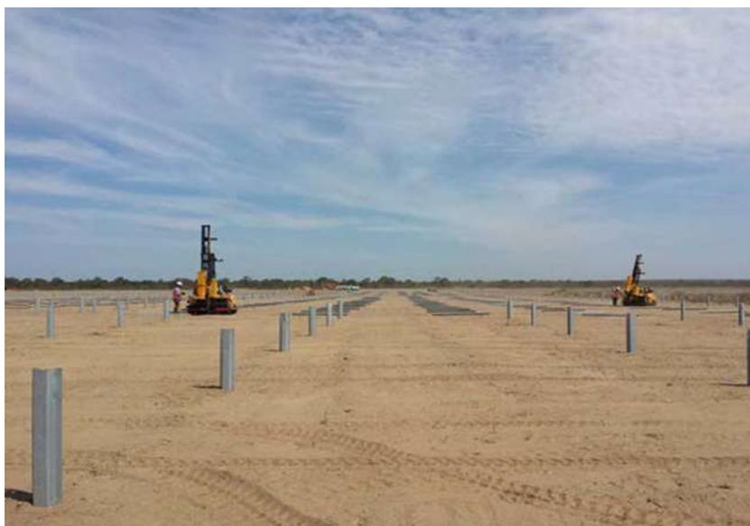
*Figura 19 – Posa in opera profili di palificazione.*
