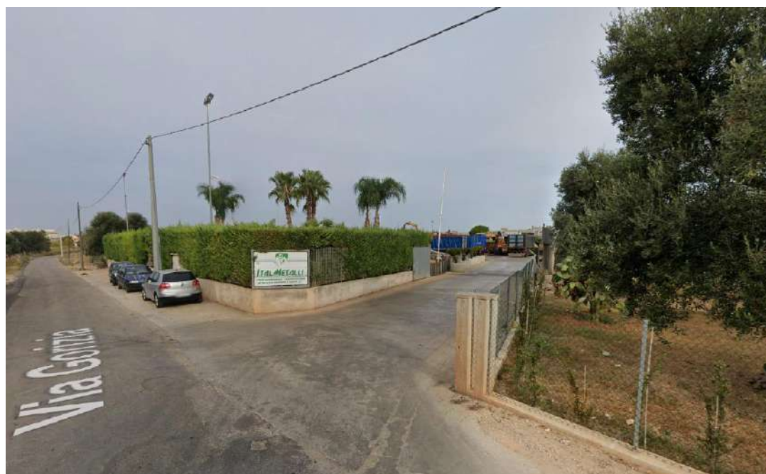
FIGURA 4: localizzazione del prospetto di ingresso dell'impianto
