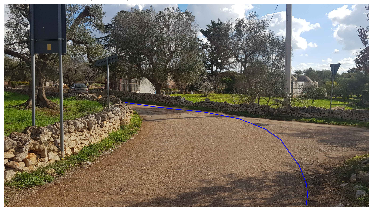
Foto 9, obiettivo verso sud - est, su strada comunale
