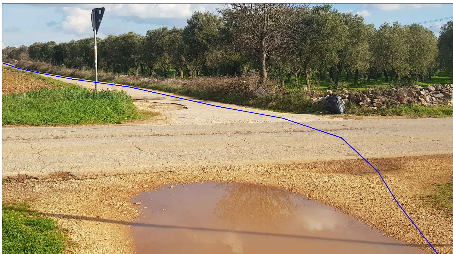
Foto 26, obiettivo verso sud - est su strada comunale ster. erso strada comunale - attravers. strada prov. n.46
