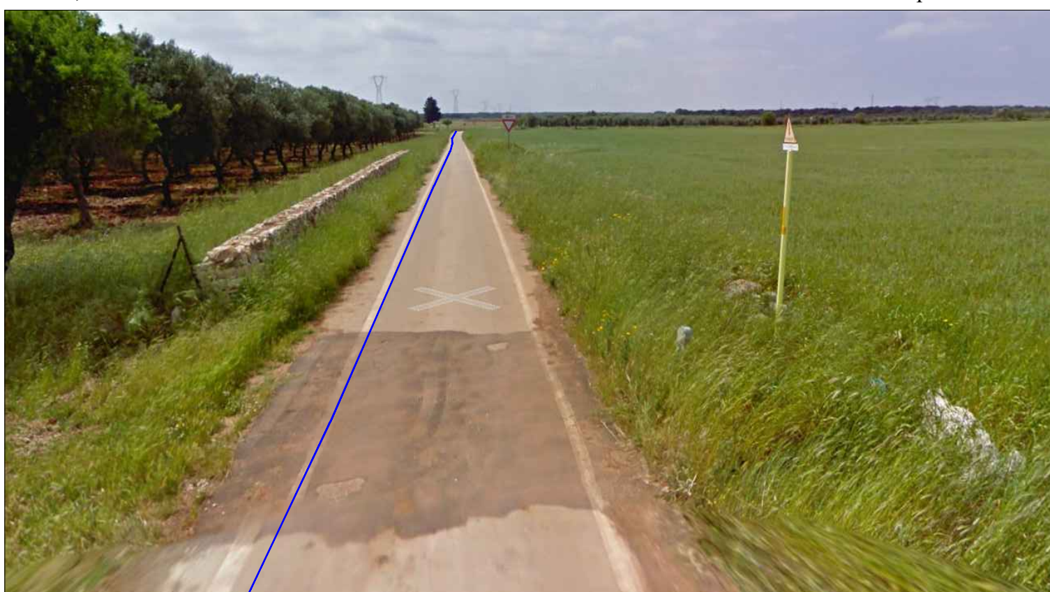
Foto 28, obiettivo verso est su strada comunale - interferenza metanodoto
