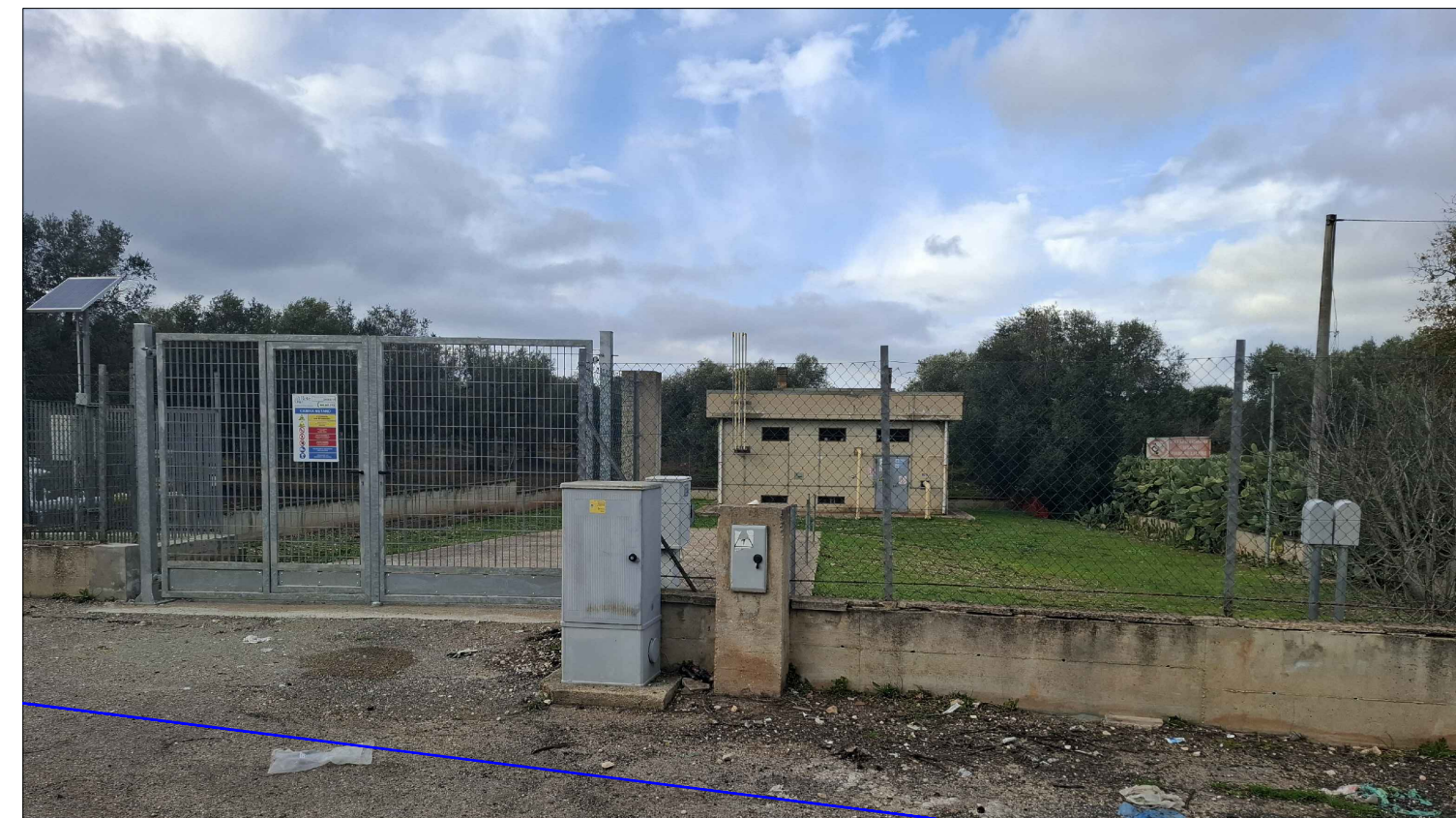
Foto 10, obiettivo verso Nord, su strada comunale
