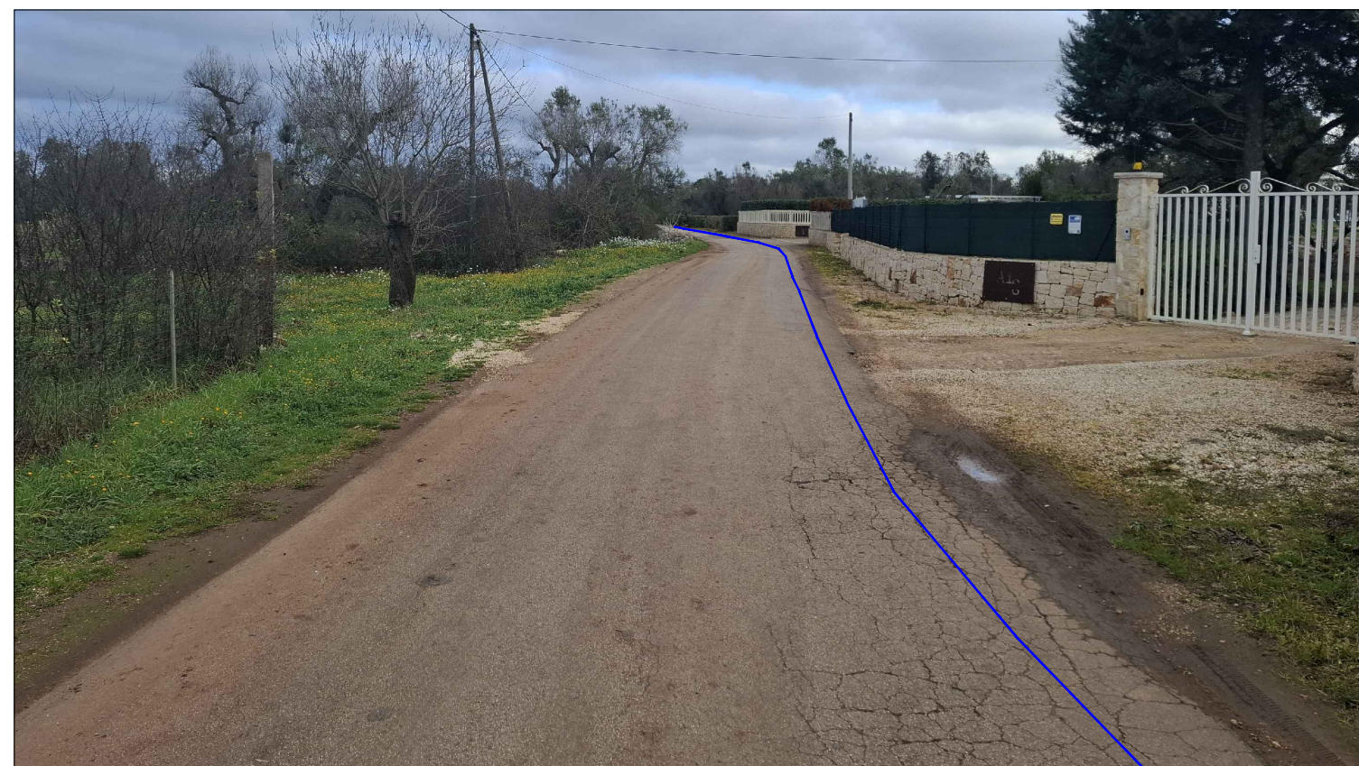
Foto 15, obiettivo verso sud - est, su strada comunale, interferenza idrologica segnalata ma non rilevata
