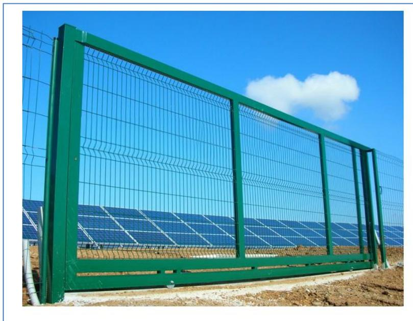
Figura 55 - cancello a struttura metallica leggera previsto in progetto
