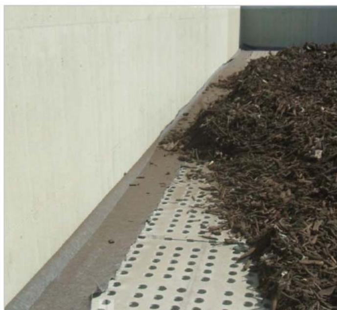
*Fig.35 – Biofiltro in fase di riempimento con corteccia di latifoglie o cippato di legno di idonea pezzatura*
