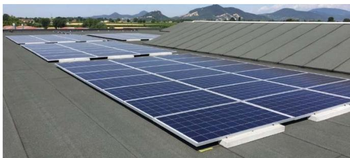
*Figura 37 Esempio posa pannelli fotovoltaici su tetto*
