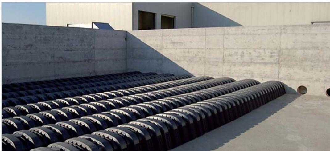
*Fig.33 – Biofiltro tipo in fase di completamento*
