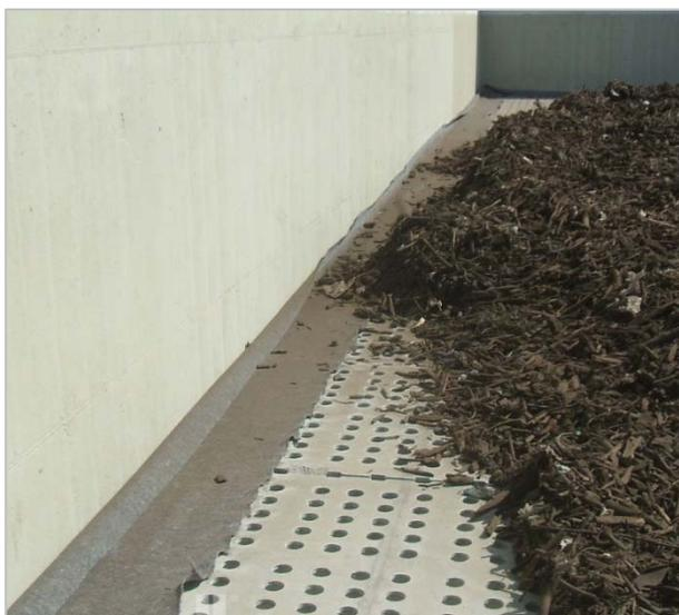
*Figura 36 Biofiltro in fase di riempimento con cotrteccia di latifoglie o cippato di legno di idonea pezzatura.*
