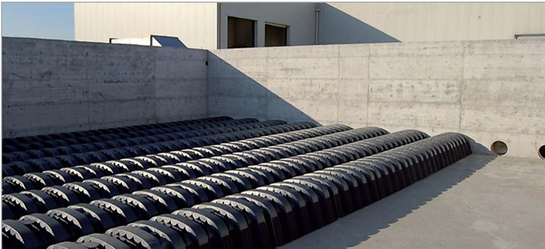
Figura 31 Biofiltro tipo in fase di completamento
