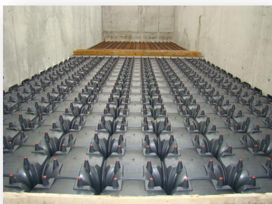
Figura 12 Pavimento Biocella in fase di realizzazione
