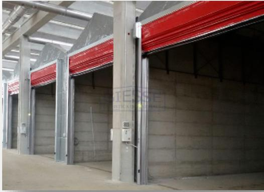
*Figura 6 Esempio biocelle*
