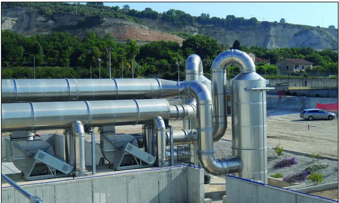
Figura 24 Scrubber adiacente biofiltro in costruzione
