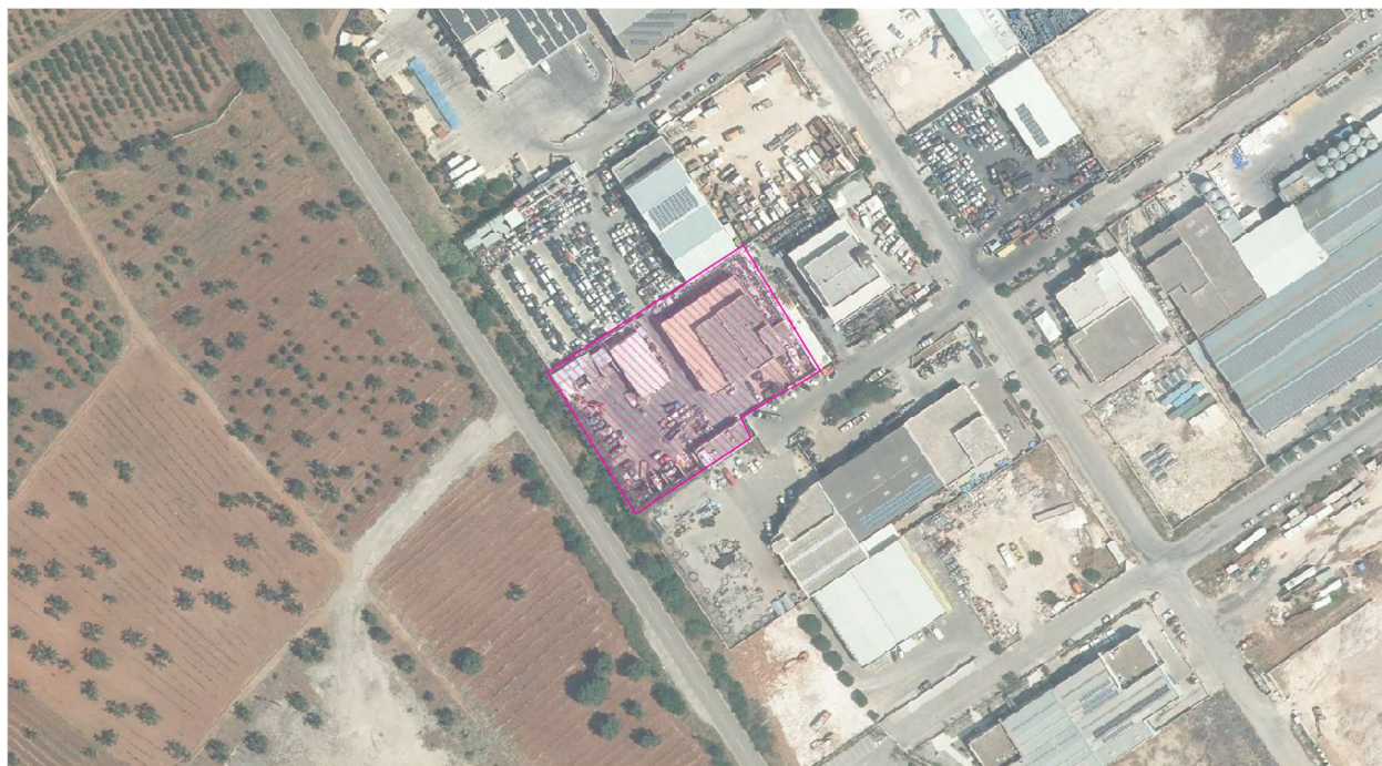
Figura 3: Impianto ECO FASO - Ortofoto 2019 fonte SIT.PUGLIA.IT
