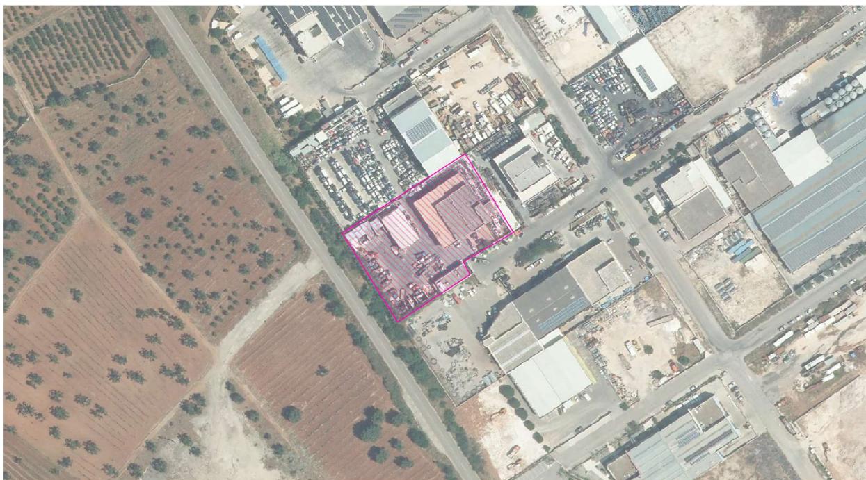
Figura 3: Impianto ECO FASO - Ortofoto 2019 fonte SIT.PUGLIA.IT
