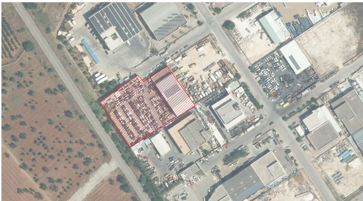
Figura 3: Impianto ECO FASO - Ortofoto 2019 fonte SIT.PUGLIA.IT
