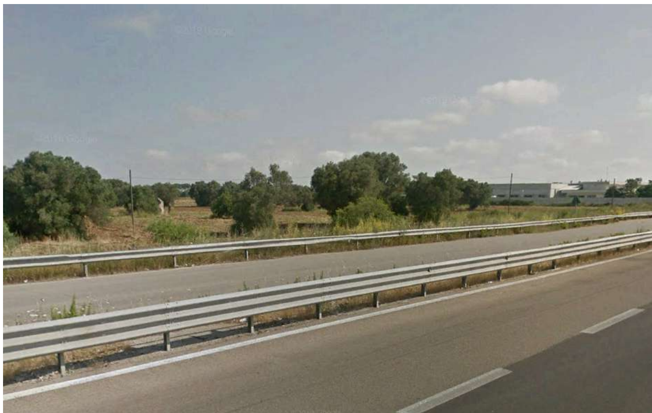
Figura 6.34 vista ovest-est dalla SS7
