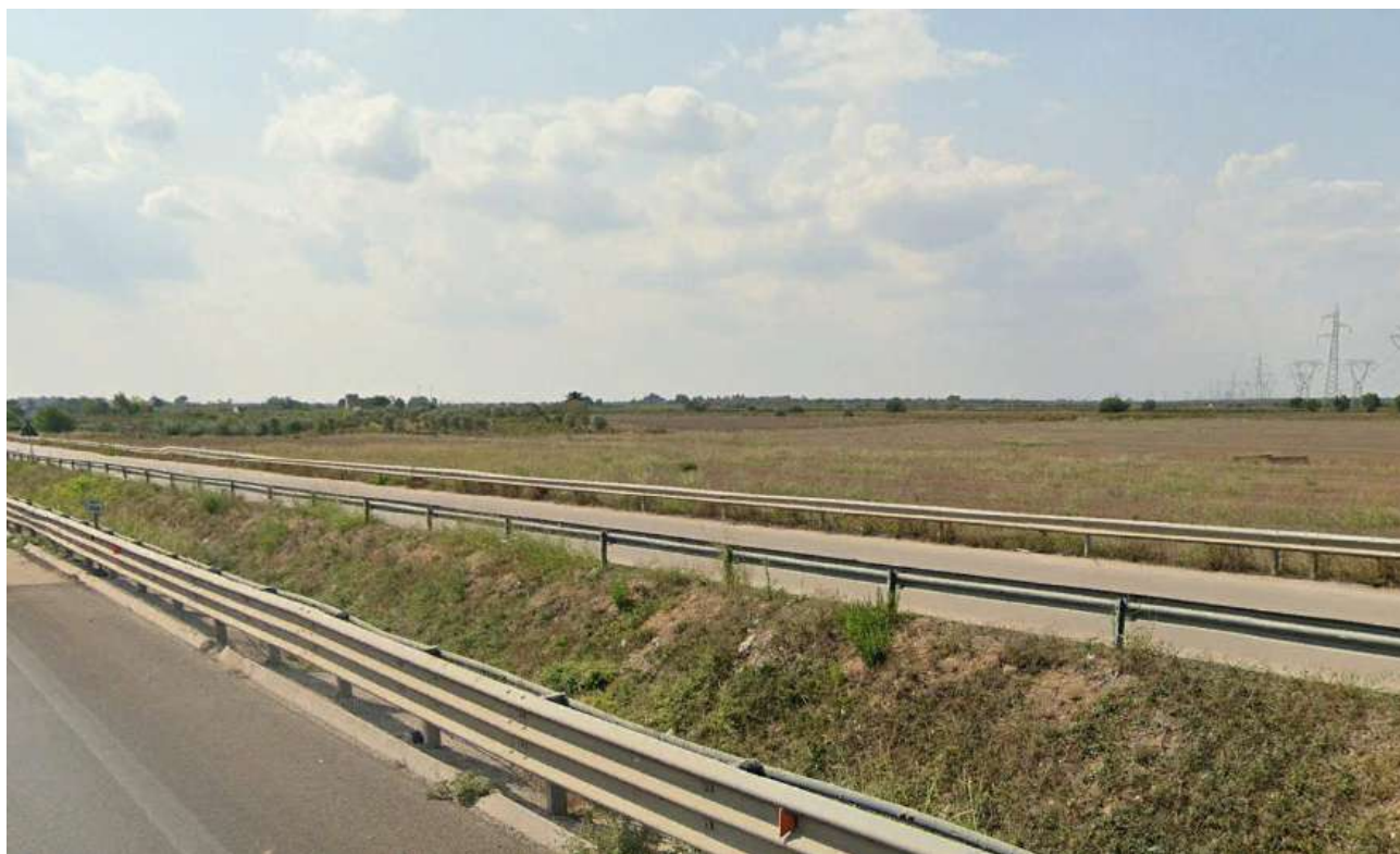
Figura 6.36 vista da est-ovest dalla SS7
