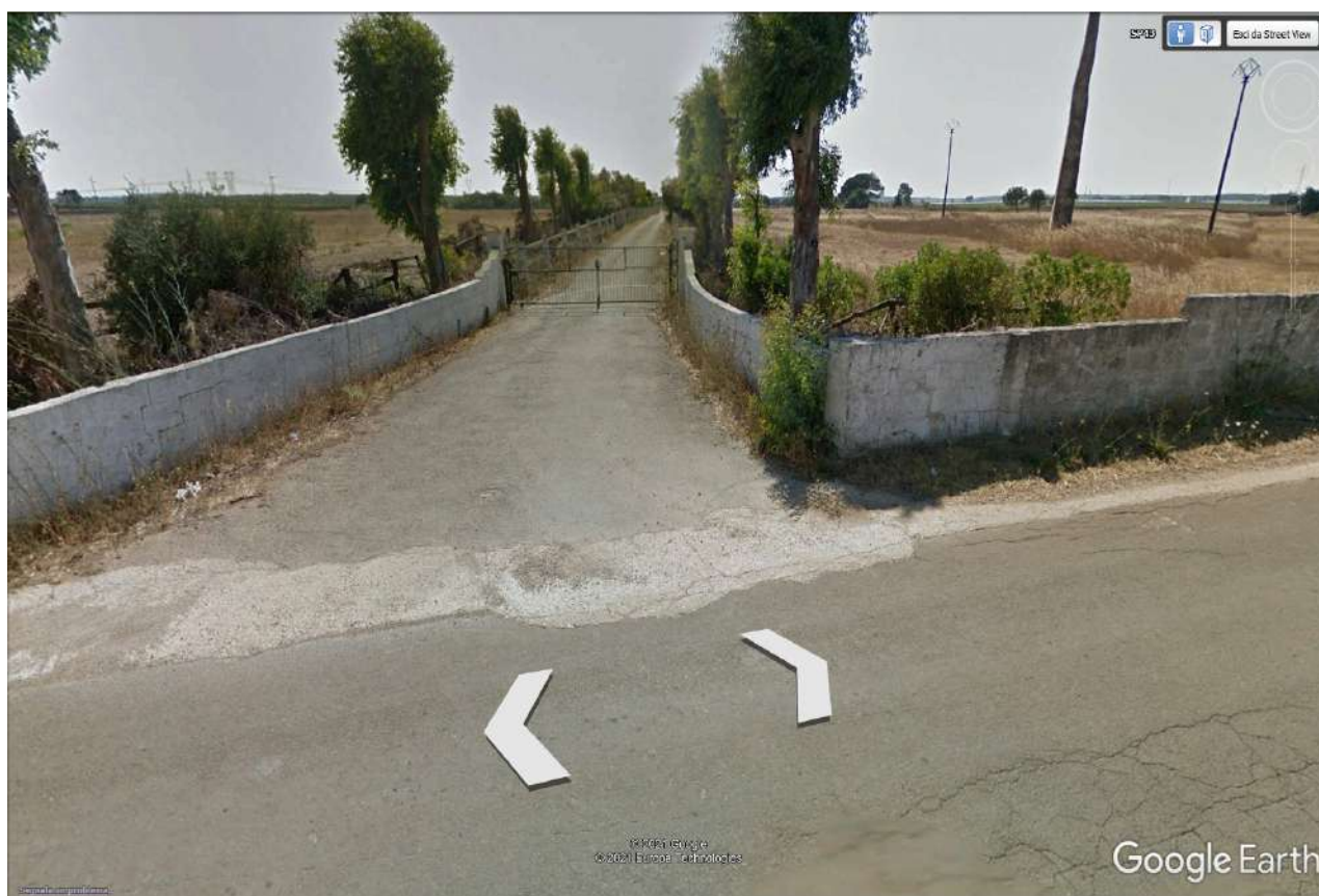
Figura 6.27 dettaglio accesso Masseria Torre Mozza
