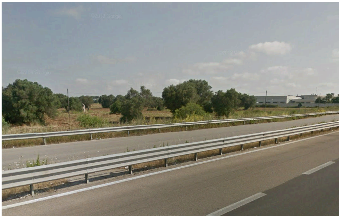
Figura 23 vista ovest-est dalla SS7
