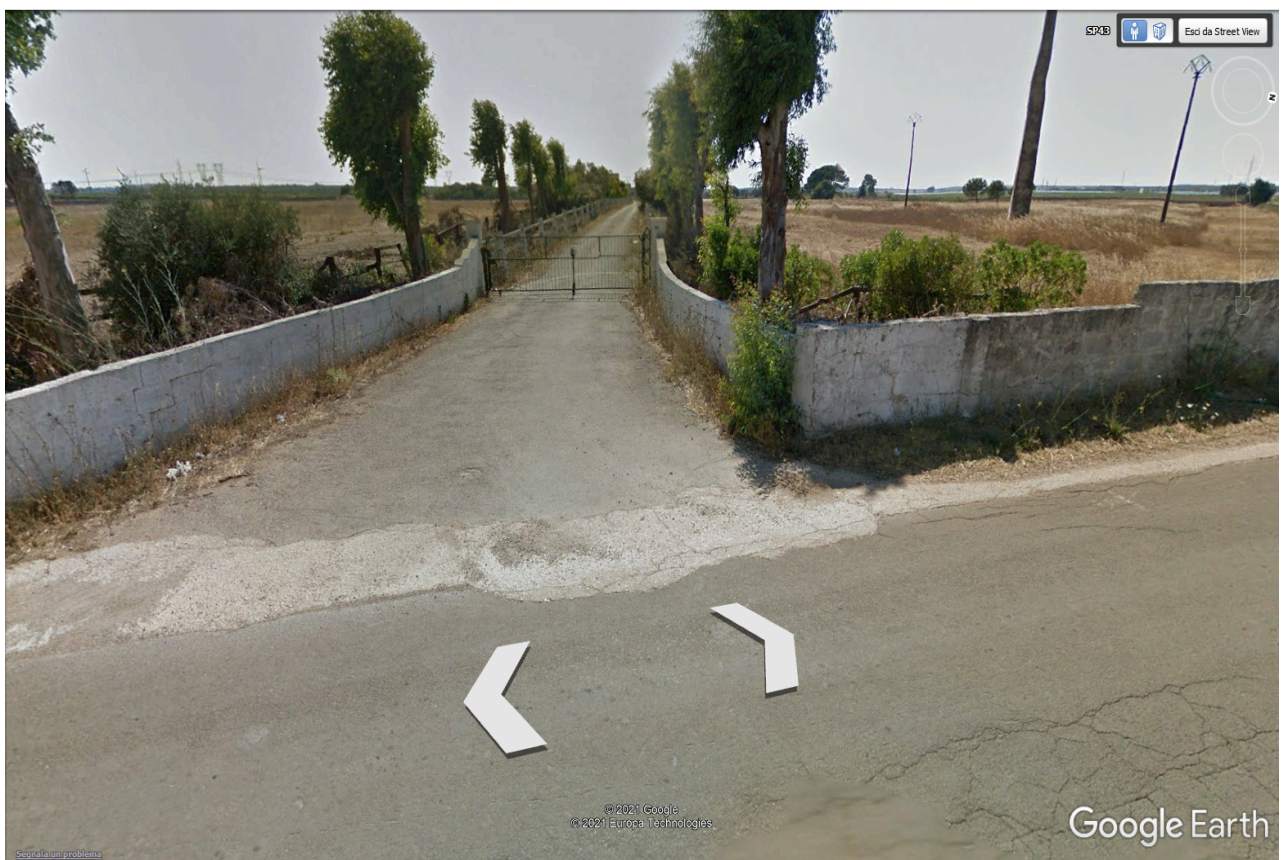
Figura 16 dettaglio accesso Masseria Torre Mozza
