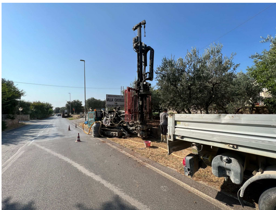
Esecuzione sondaggio geognostico a carotaggio continuo S1
