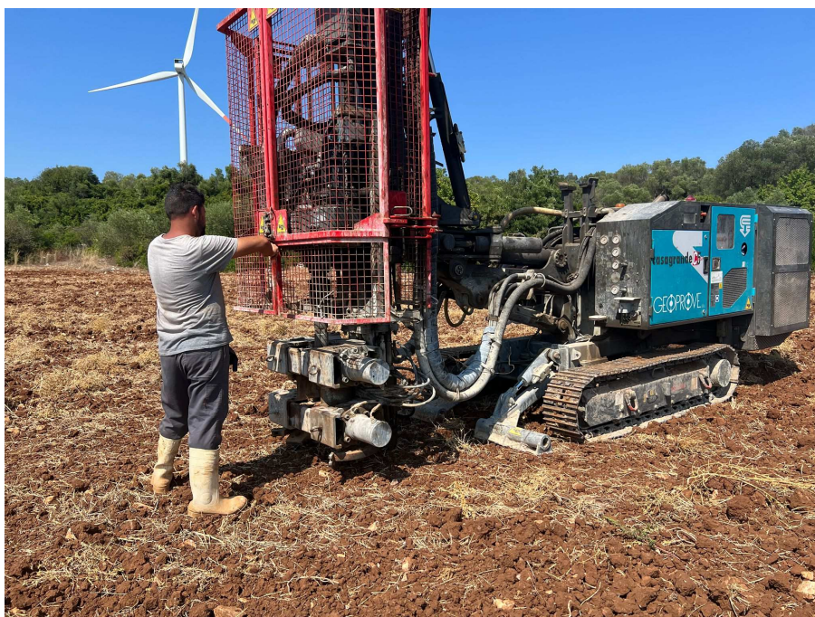
Esecuzione sondaggio geognostico a carotaggio continuo S6
