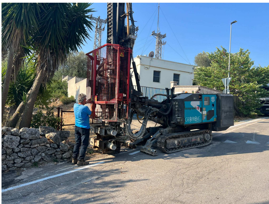
Esecuzione sondaggio geognostico a carotaggio continuo S4
