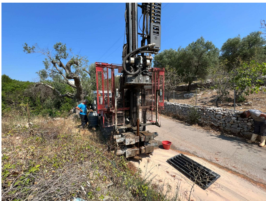
Esecuzione sondaggio geognostico a carotaggio continuo S5
