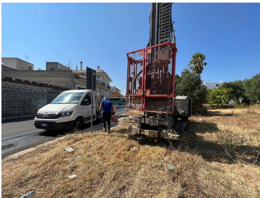
Esecuzione sondaggio geognostico a carotaggio continuo S3
